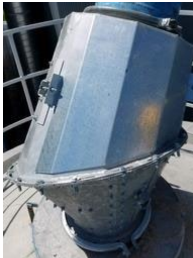
Figura 4.6. Ejemplo de una caja de cojín que reduce la velocidad del grano a medida que el flujo de grano entra en contacto con el "cojín" como resultado del grano en contacto con el grano en lugar de las superficies metálicas.
