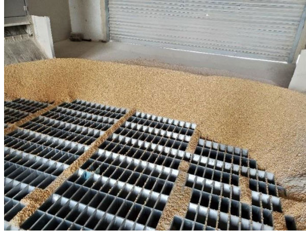
Figura 4.4. Rejilla de pozo de recepción típica diseñada como primera línea de defensa para evitar que el material no deseado ingrese a la corriente de grano.
