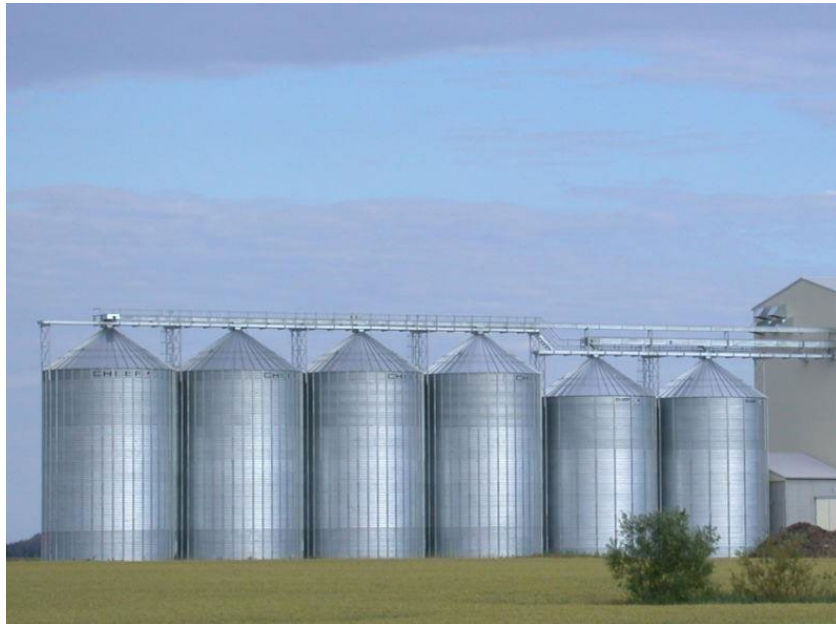
Figura 4.13. Silos de acero corrugado y atornillado que sostienen maíz a granel en una fábrica de piensos.
